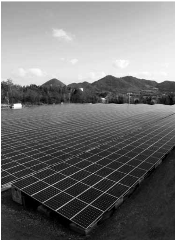
▲十河正信相談役を中心に高松南倫理法人会のメンバーで立ち上げた「うどん県電力」の国分寺発電所
